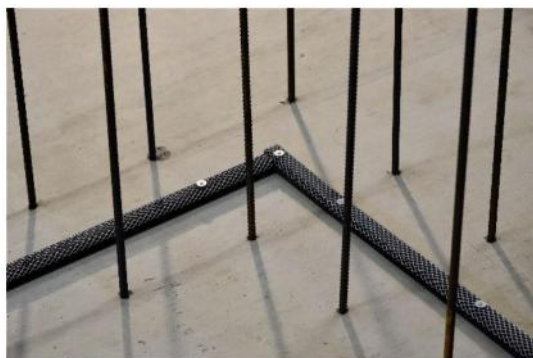
Fissaggio con WS Rete 25/20
