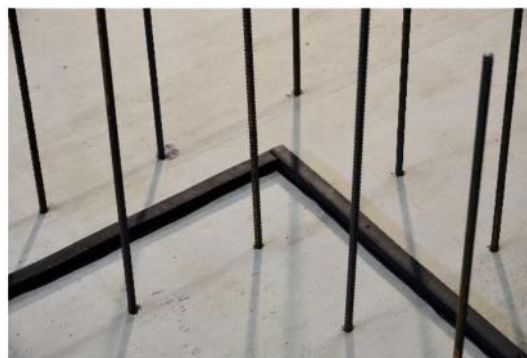
Fissaggio con WS colla
